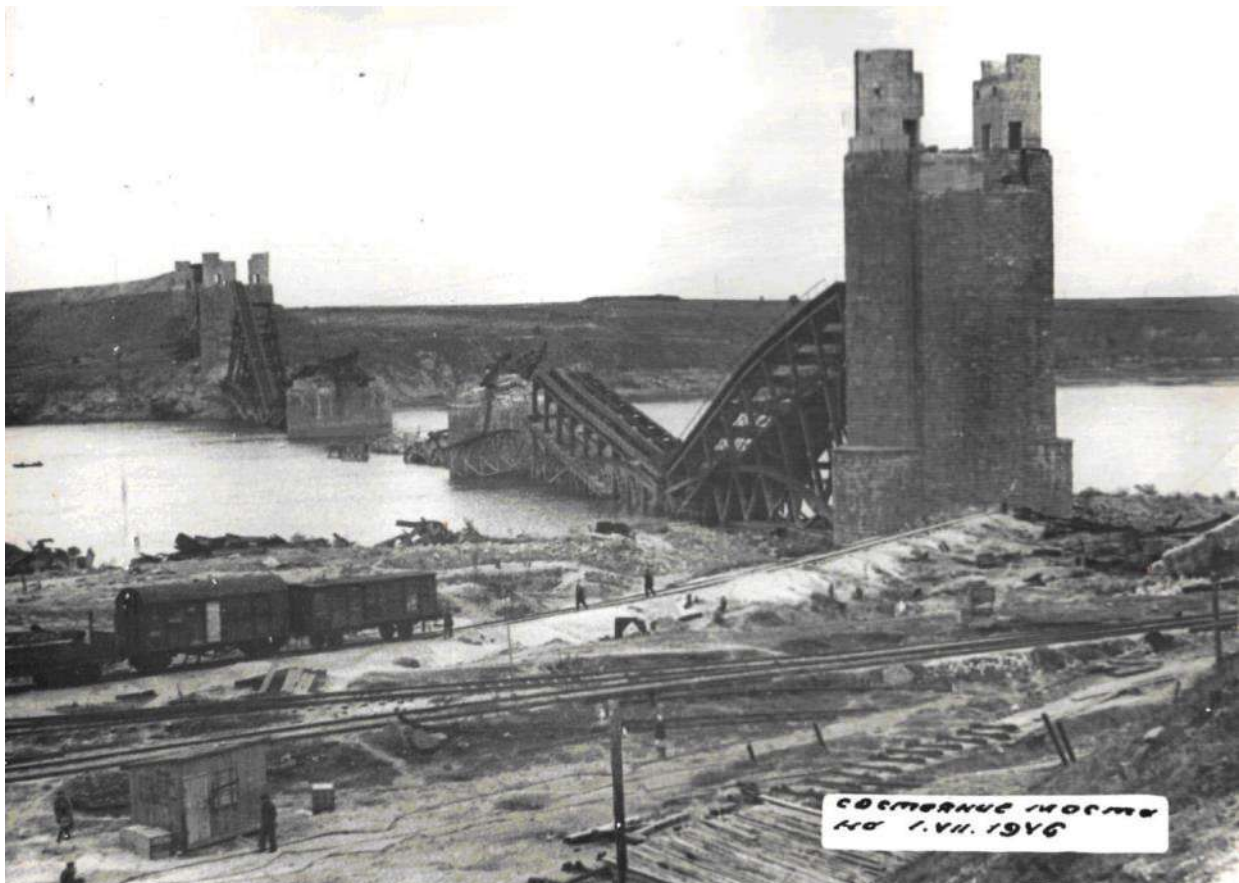
Зруйнований міст Стрелецького через Новий Дніпро. 1946 р.
